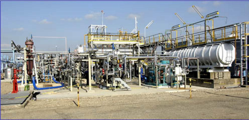
*« En contexte EOR, l'objectif des tests réalisés sur la plateforme GOwSP est d'étudier à une échelle semi-industrielle de nouvelles technologies ou l'impact d'additifs chimiques sur la qualité de la séparation eau/huile. Ces tests, en conditions représentatives, viennent à la suite d'un screening chimique effectué en amont à l'échelle laboratoire. C'est une étape de validation qui permet de réduire les risques portant sur des opérations réalisées à l'échelle d'un champ. »*
