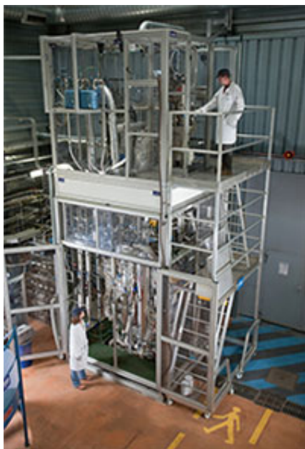
Pilote CLC IFPEN/TotalEnergies à IFPEN-Lyon
